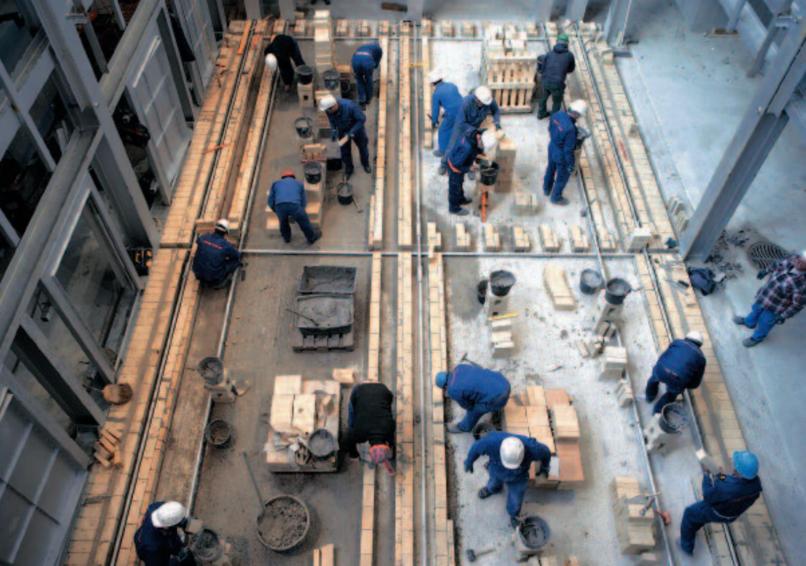
*Aufbau der Wärmekammern im Werk St-Prex (Schweiz).*
