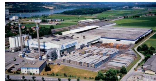
Plant Pöchlarn (Austria)
