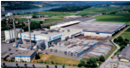
Plant Pöchlarn (Austria)
