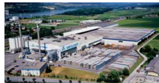
Plant Pöchlarn (Austria)
