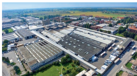
Trezzano sul Naviglio Plant, Italy
