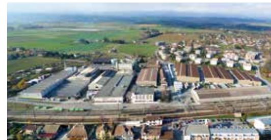
Usine de St-Prex (Suisse)
