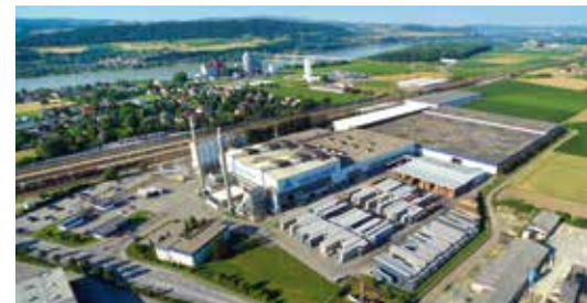
Usine de Pöchlarn (Autriche)
