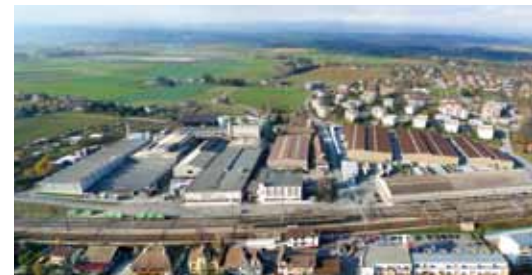
Usine de St-Prex (Suisse)
