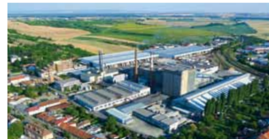
Usine de Kyjov (République Tchèque)
