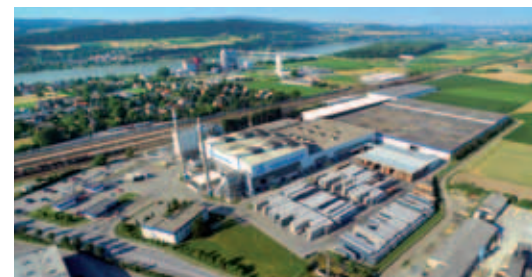
Usine de Pöchlarn (Autriche)
