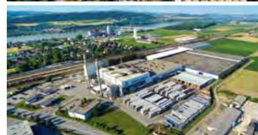
Usine Pöchlarn (Autriche)
