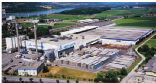
Usine Pöchlarn (Autriche)
