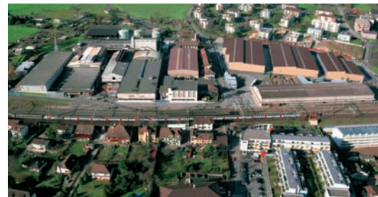
Usine de St-Prex (Suisse)
