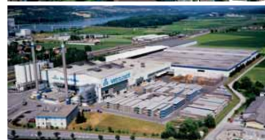
Usine de Pöchlarn (Autriche)
