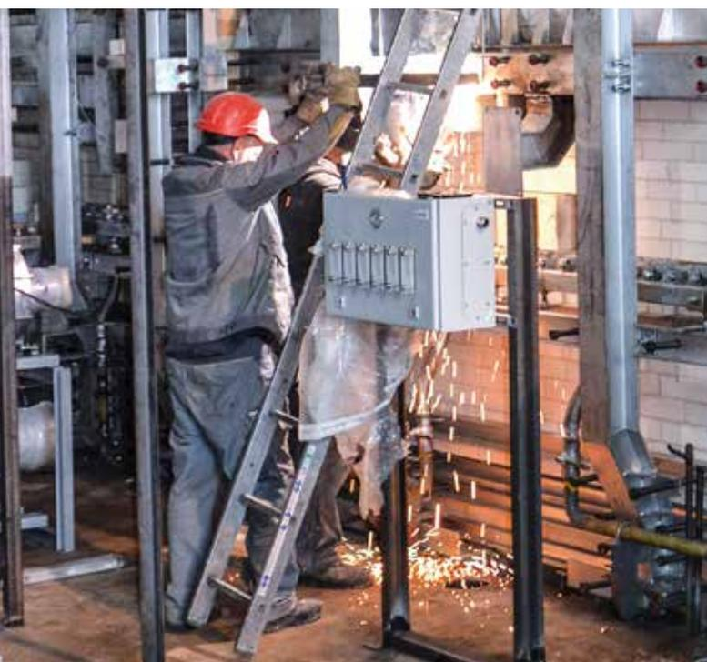
gaz d'échappement et la consommation d'énergie du bassin de fusion. Le fond du bassin, l'avant-creuset ainsi que les équipements destinés à la filtration des gaz d'échappement et le contrôle automatique du bassin ont été entièrement renouvelés. Résultat: une baisse des coûts énergétiques et une augmentation globale de la capacité du bassin.
