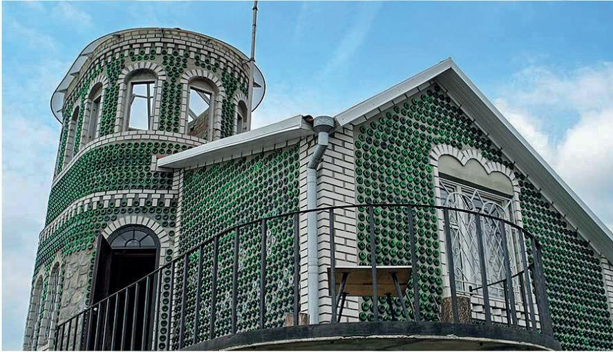
La photo d'une maison fabriquée en bouteilles en verre a tellement impressionné Volodymyr Sysa qu'il en a construit une. Il a investi tout son temps dans son projet, dessiné les plans et soigneusement collecté les bouteilles de vin mousseux. Les bouteilles remplies de mortier créent un coussin d'air qui maintient la température dans cette construction. Il y fait frais l'été et chaud l'hiver. La maison est située dans une banlieue de Zaporizhia, en Ukraine.
