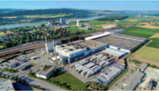
Pöchlarn Plant (Austria)
