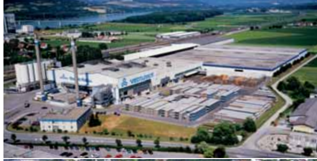
Pöchlarn Plant (Austria)
